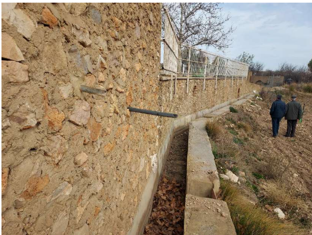
Ejemplo de tramo de acequia de hormigón en un estado aceptable
