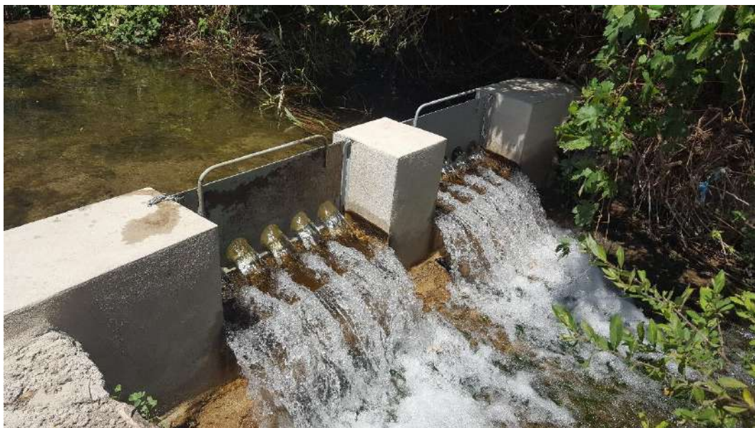
Ejemplo de presa rehabilitada recientemente con orificios para permitir la circulación de caudal ecológico
