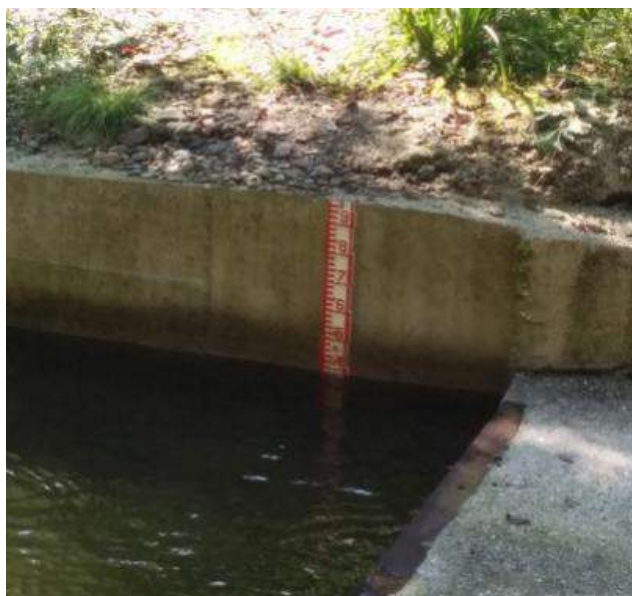
Sección de control de hormigón y escala limnimétrica para la cola de la infraestructura
