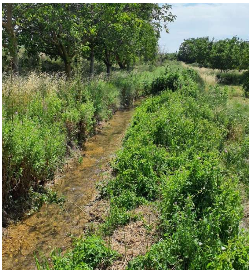
2 Canal de tierra a sustituir por canal de obra en la Toma-8
